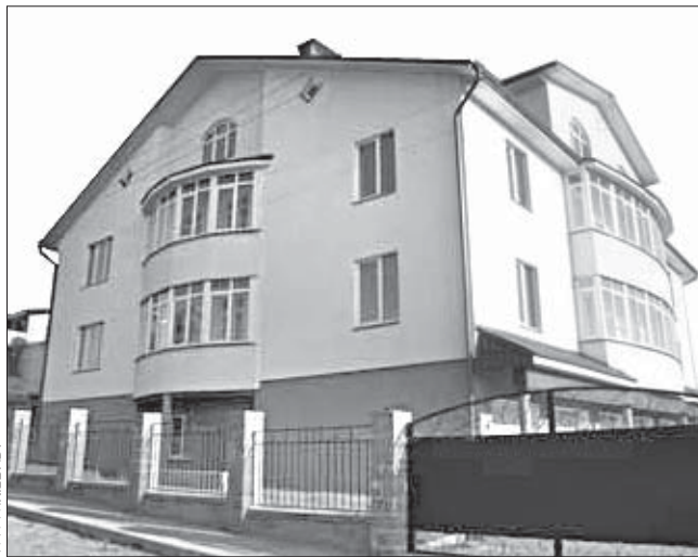
Двухузроўневая кватэра ў малакватэрным доме на вуліцы Вясновай у сталіцы цяпер каштуе 210 тысяч даляраў.
