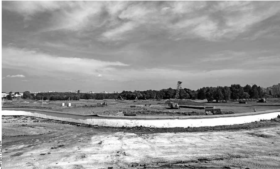
Паміж «БелЭкспа» і Свіслаччу — вялікая будпляцоўка.
