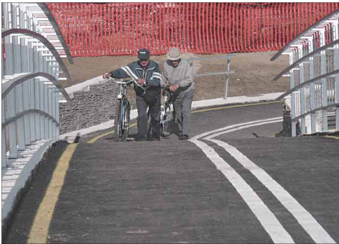
Мост цераз Свіслач. Не ровар в'язе чалавека, а наадварот.
